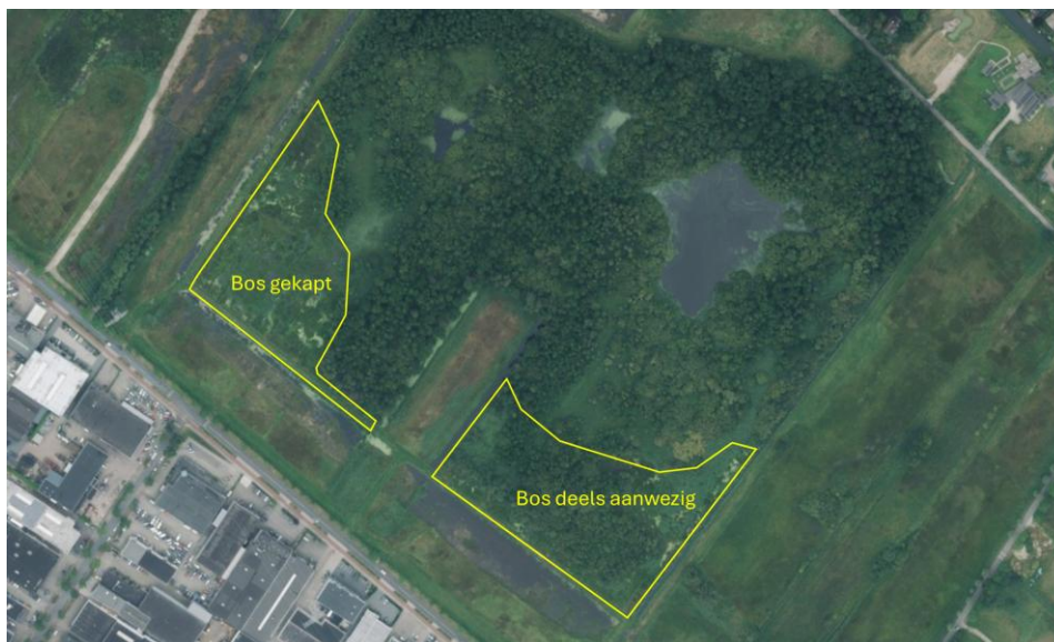
Figuur 3-5. Werkzaamheden in deelgebied 4 van De Hellen. Een deel van de begroeiing is nog steeds aanwezig.
