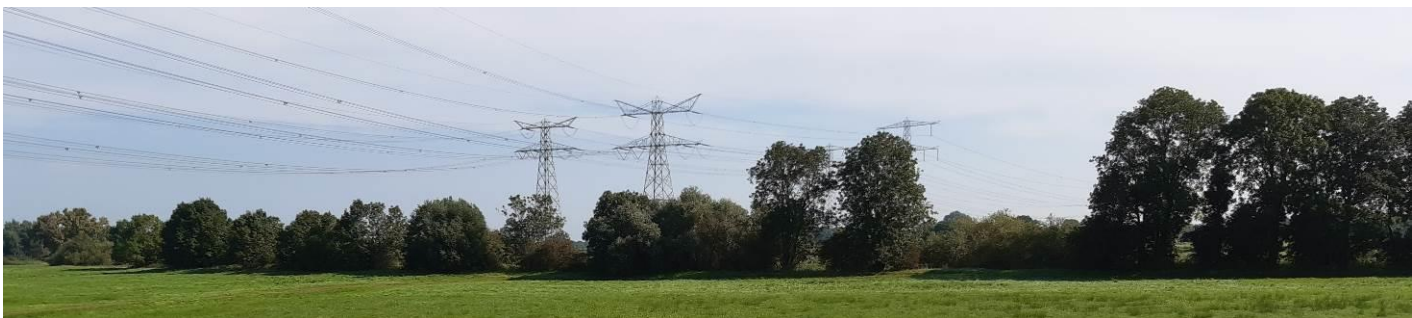
De strook droog hardhoutooibos gezien vanaf de Zwarte water dijk. De hoogspanningsleiding overkruist deze smalle bosstrook.
