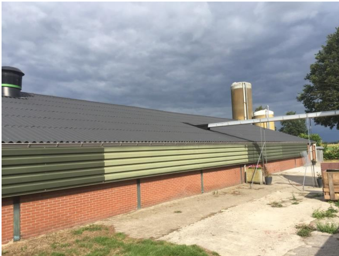
Foto 2. Dak uitvoering stal 1.
