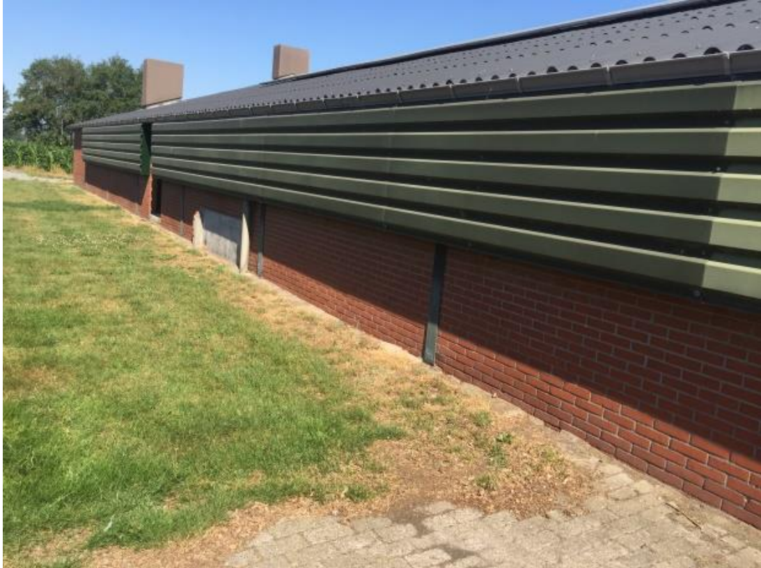
Foto 6. Flens spantbeen aan buitenzijde.
