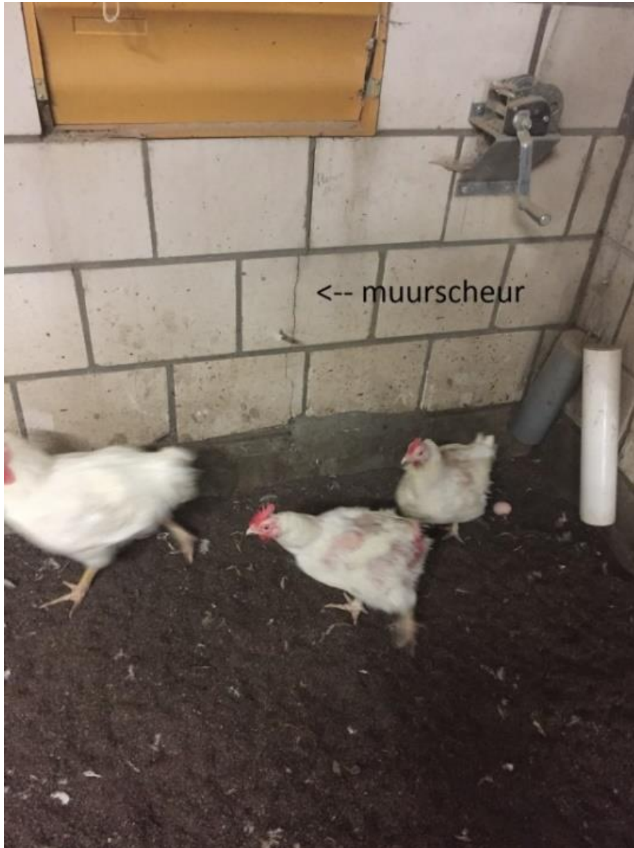
Foto 16. Scheur in binnenblad van stal 2.
