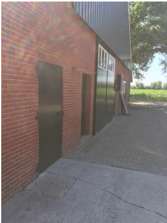
Foto 34. Achtergevel van gebouw B.
