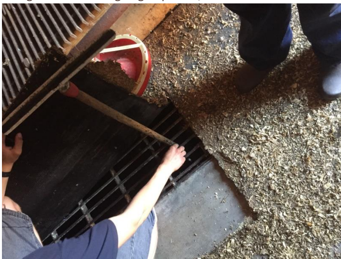
Foto 39. Vloer begaande vloer in gebouw B.
