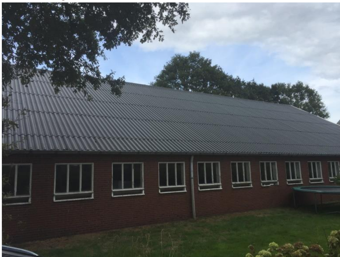
Foto 33. Dakuitvoering gebouw B (linkerzijgevel).
