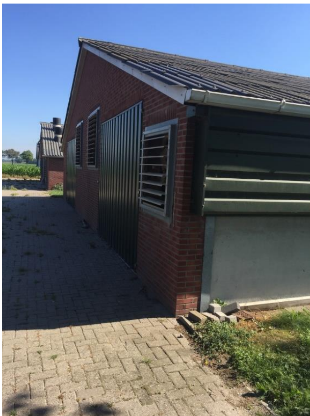
Foto 17. Achterzijde dak-uitvoering stal 3.
