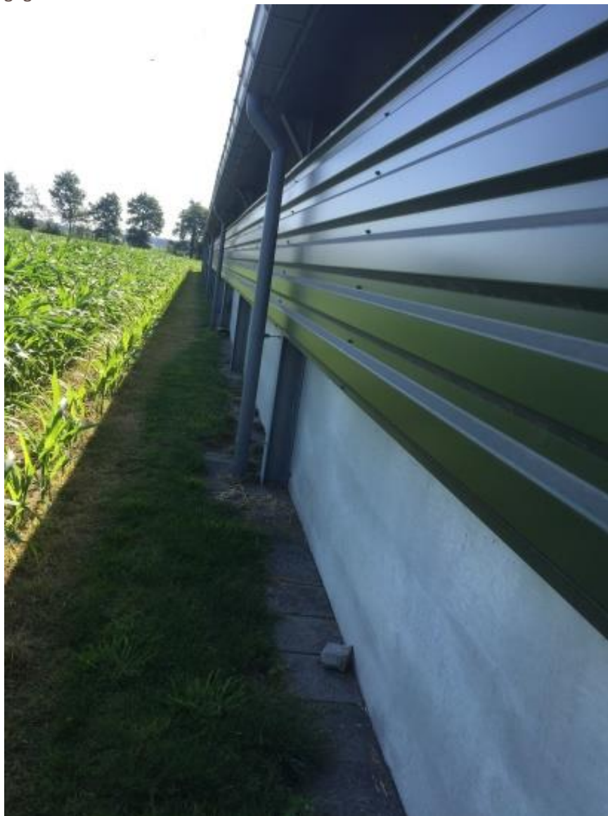
Foto 31. Spantconstructie prefab betonpanelen.
