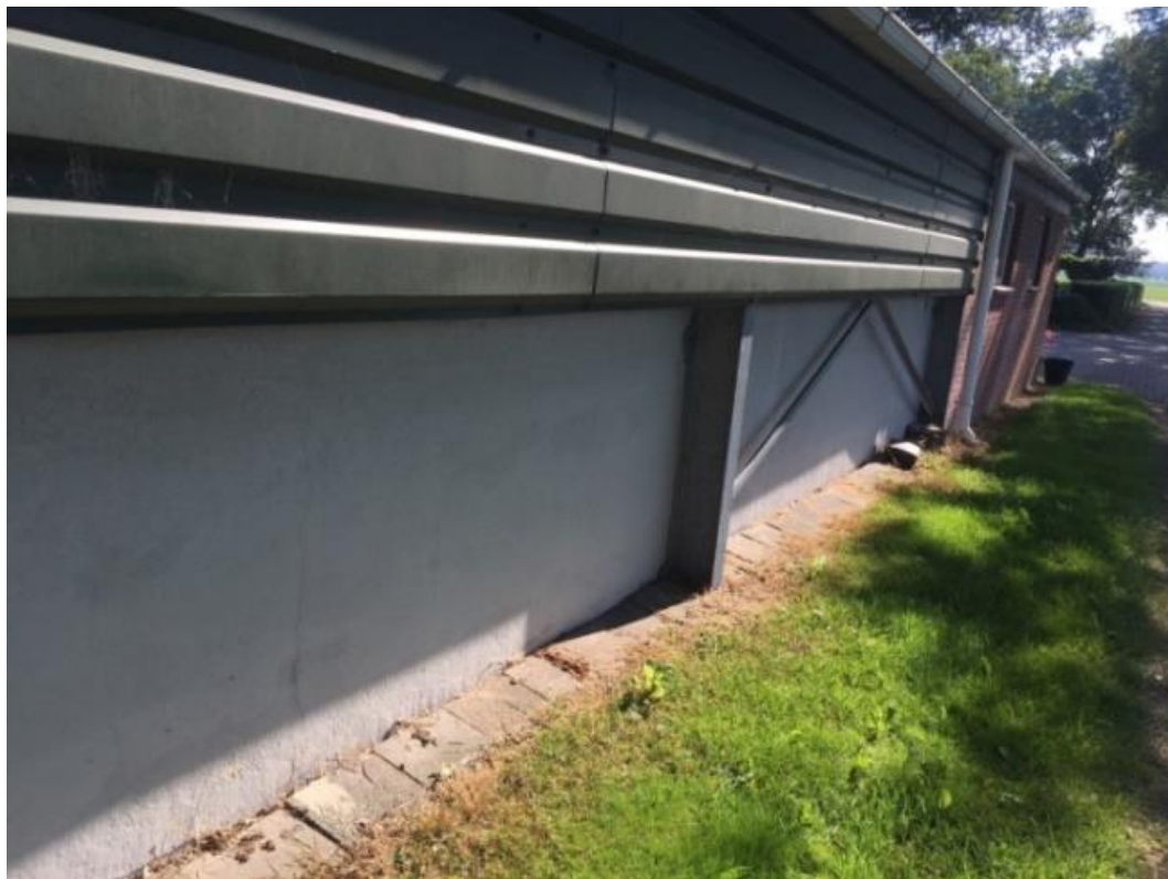
Foto 22. Spantconstructie bij prefab betonpanelen.
