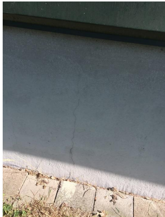
Foto 19. Haarscheur in de zijgevel van stal 3.
