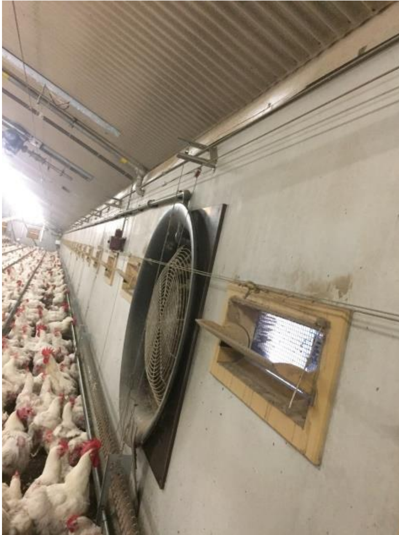
Foto 30. Aluminium profielplaten met isolatie erboven.
