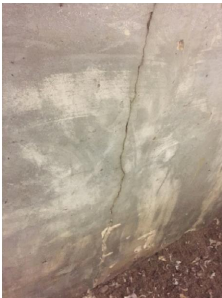
Foto 7. Scheur in de binnenblad van stal 1.
