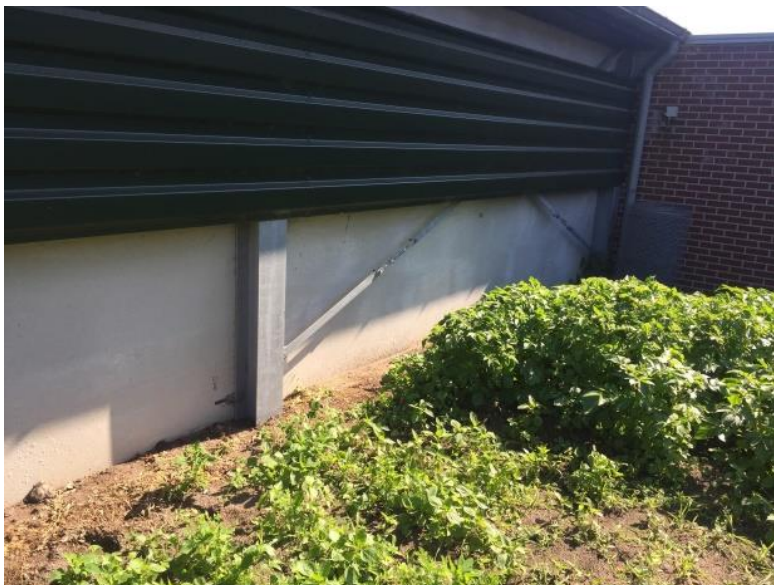
Foto 27. Zijgevel stal 4 en tussenverbinding van stal 3-4.
