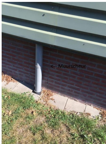
Foto 11. Scheur in de voorgevel van stal 2. Foto 12. Scheur in de zijgevel van stal 2.
