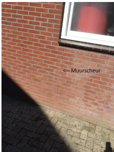
Foto 11. Scheur in de voorgevel van stal 2. Foto 12. Scheur in de zijgevel van stal 2.
