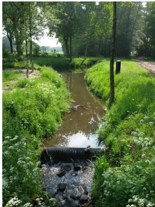
Afbeelding 1: Drempels in de Mosbeek. de tweede drempel in traject 2 (foto links) en de drempel in traject 6 (foto rechts) zijn niet passeerbaar voor vissen.
