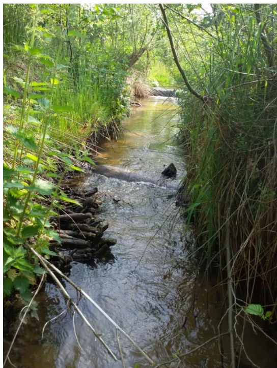
Afbeelding 1: Drempels in de Mosbeek. de tweede drempel in traject 2 (foto links) en de drempel in traject 6 (foto rechts) zijn niet passeerbaar voor vissen.
