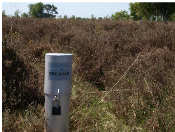
Waterpeilbuis: meten is weten (foto: Hans Dekker)
