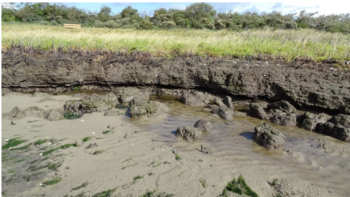
Figuur 3 Steile kwelderrand onder het Oerd, ontstaan door afkalving (foto: augustus 2020).
