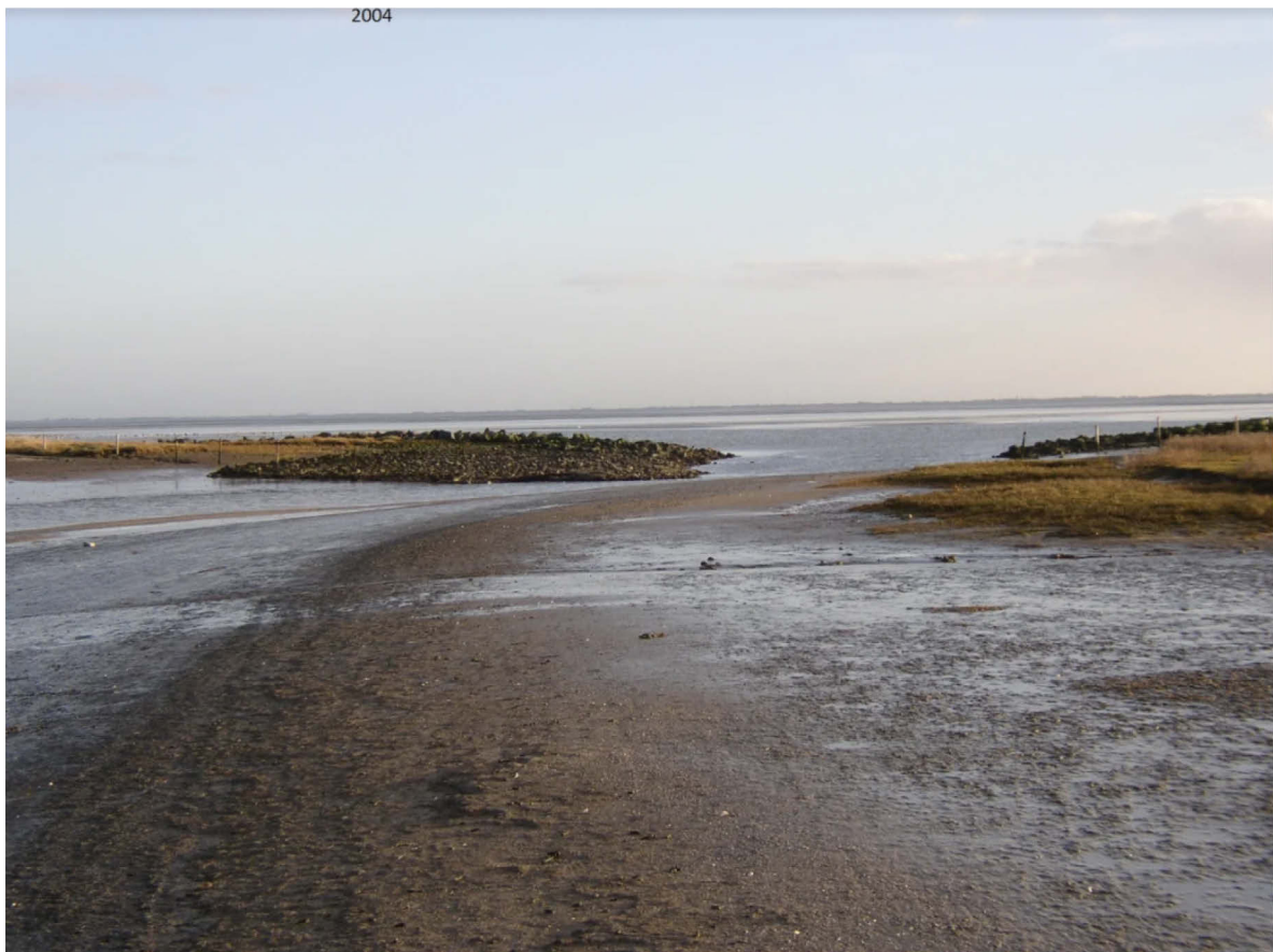
Figuur 17 Monding van de Oerdsloot. Duidelijk zichtbaar de oeververdediging met stortstenen aan linker- en rechterzijde van de monding (foto 2004).
